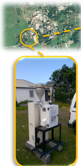
Figure 5 : Site de prélèvement de proximité industriel au Moule
