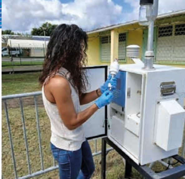
Ingénieure d'études récupérant les prélèvements de pesticides sur le site de mesure de Belair à Capesterre-Belle-Eau
