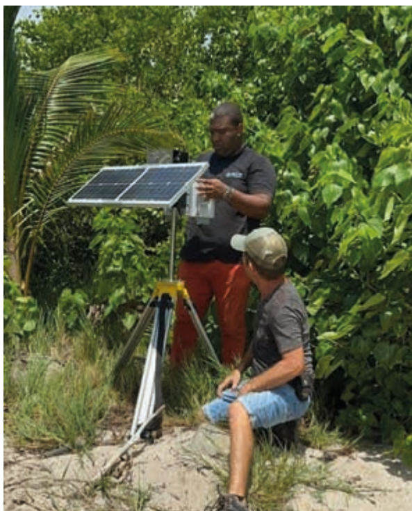
Maintenance des capteurs pour la mesure des Sargasses à Saint-Barthélémy
